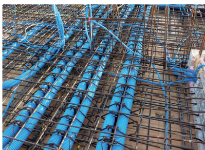
platzsparende Verstärkung mit je zwei Einlagen pro Element
