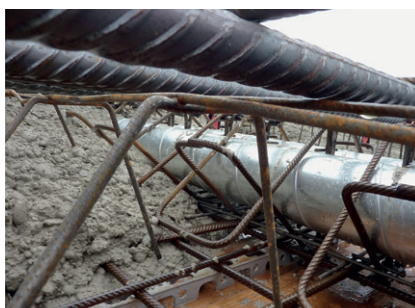
Jederzeit kontrollierte Lagesicherung der Einlagen
