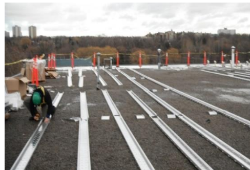
Fig. 3 – Align Rails
