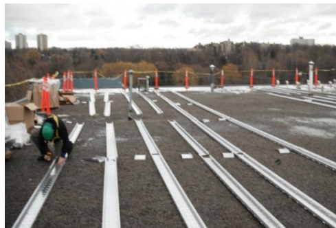
Fig. 3 – Align Rails
