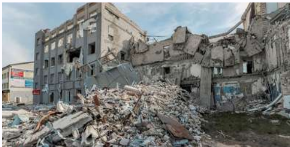
Зруйнована будівля в Херсоні, 18 квітня 2023 р. (Азіз Карімов/SOPA, Зображення через Shutterstock)
