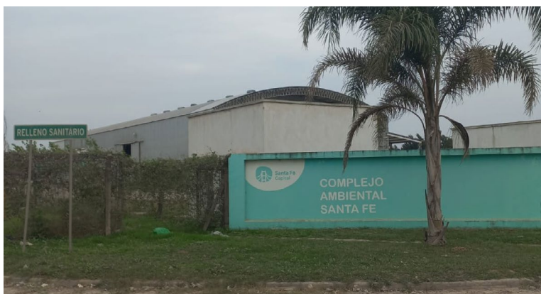
Figura 20: Instalaciones del Complejo Ambiental Santa Fe
