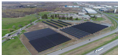
Centrale solaire de HQ - 1,5 MW
