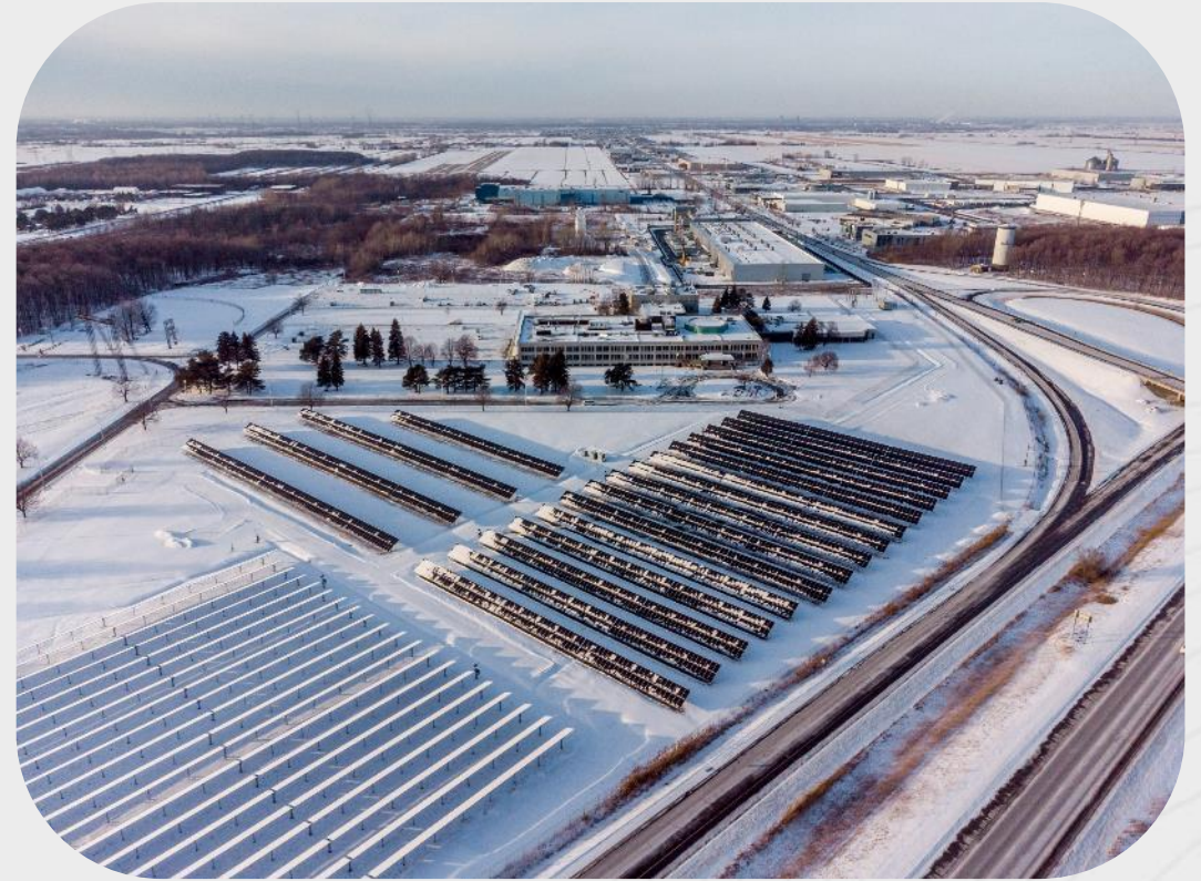
Parc solaire (terrain d'Hydro-Québec)
