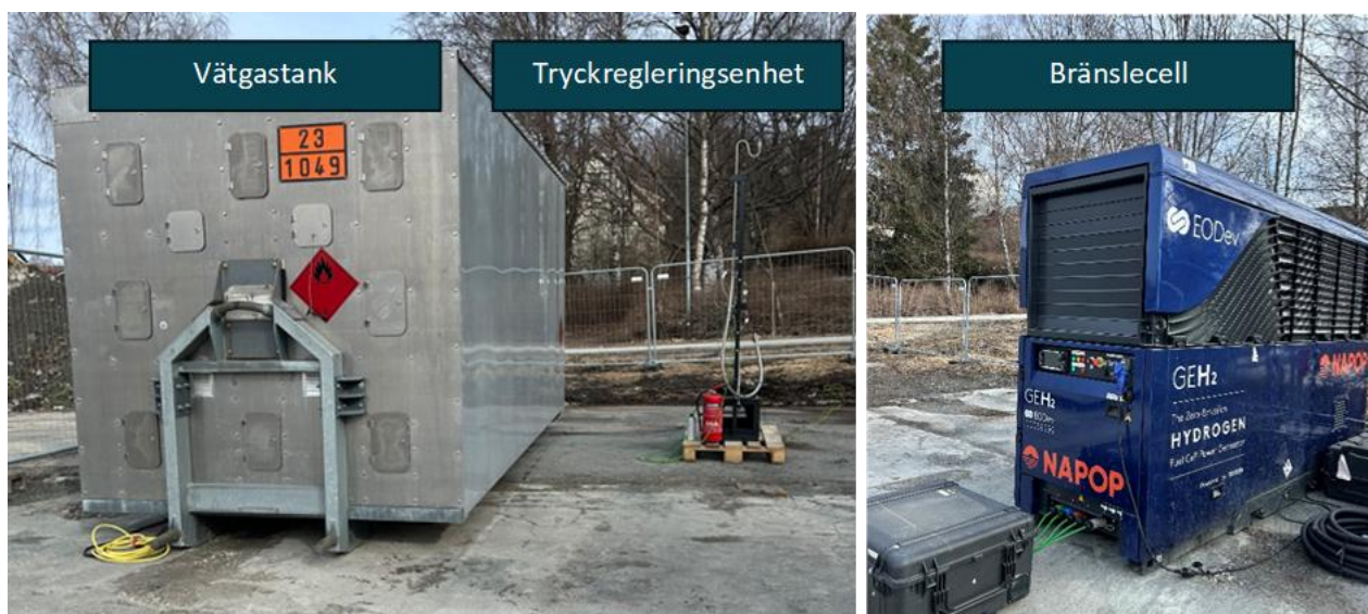
Figur 5 - NAPOPs Vätgasanläggning i Granprojektet. 18
