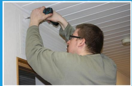
Säleiköt kiinnitetään paikoilleen ja asennus on valmis. Säleikkö asennetaan siten että ilmavirtaus on kattoon päin.
