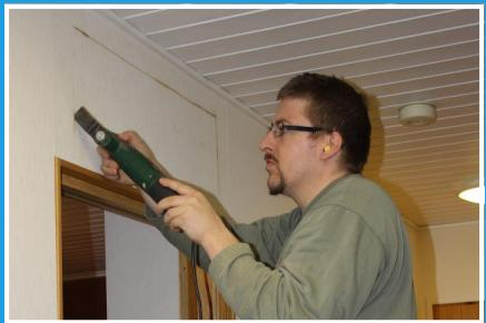
Oven yläpuolelle tehdään  $550 \times 215$  mm kokoinen aukko. Sen voi tehdä myös muualle kuin oven yläpuolelle, mutta mielellään seinän yläosaan.
