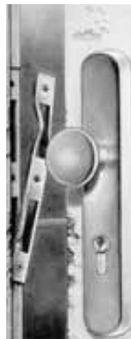
Bild 3-23: Ausgerissenes Schließblech
