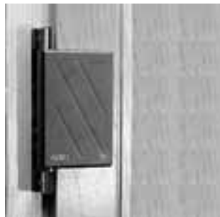
Bild 3-26: Bandseitensicherung
