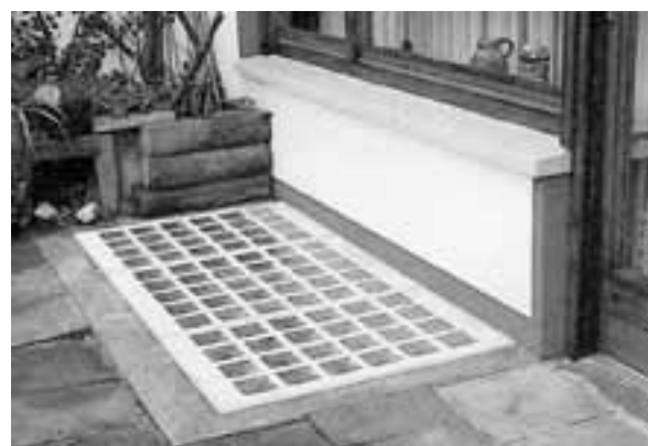
Bild 3-47: Abdeckung mit Glasbausteinen
