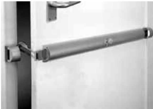
Bild 3-29: Querriegelschloss mit Sperrbügel
