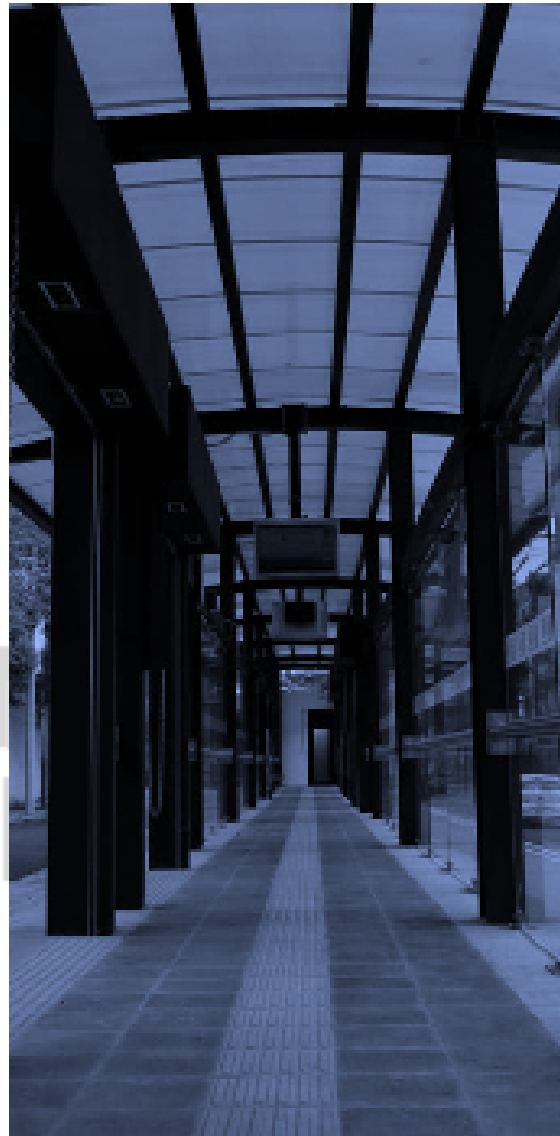
Línea 6 de Metrobús
