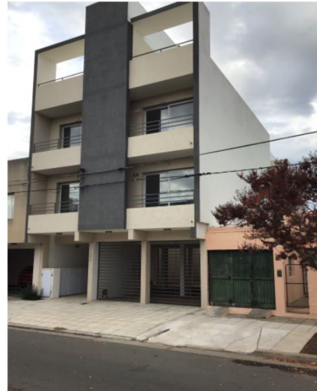
Edificio de condominios de 42 m2 año 2016. ARGENTINA.
