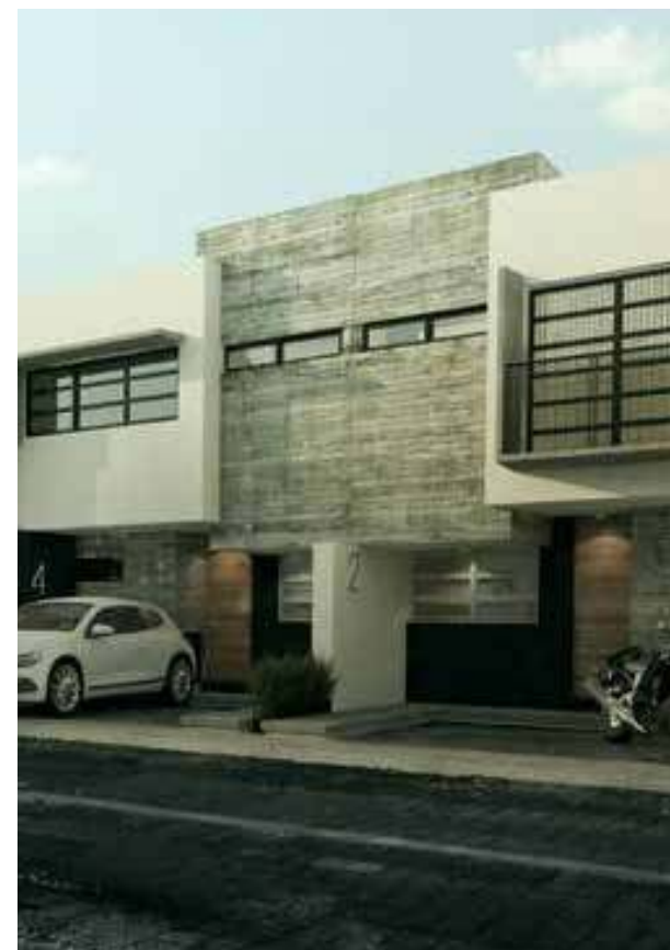
Fraccionamiento "Punta de Otero" Construcción de 58 viviendas, Zapopan, Jalisco
