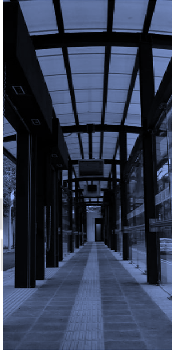
Línea 6 de Metrobús
