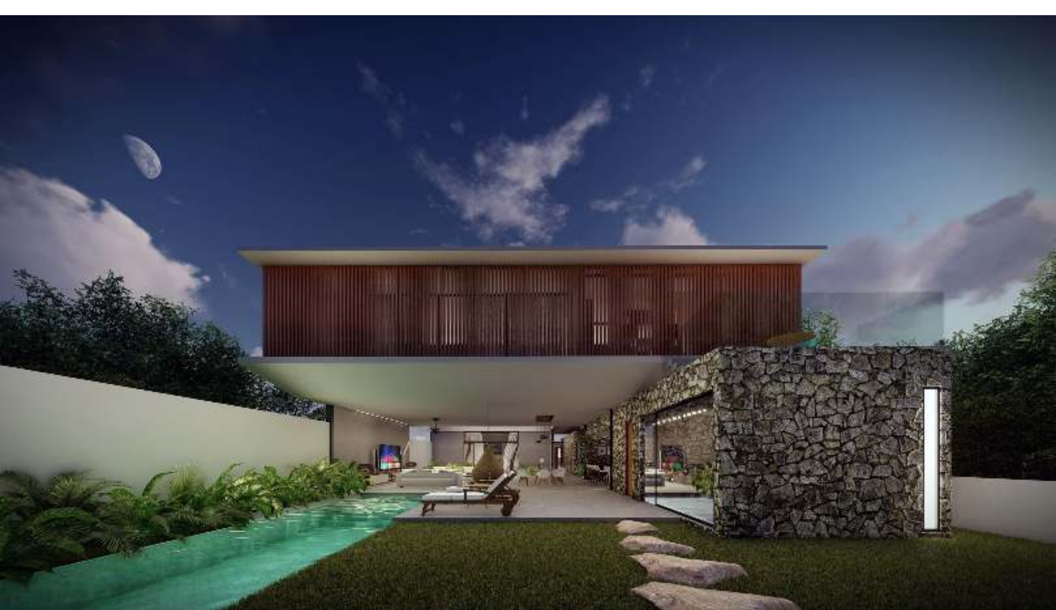
Fachada Secundaria Cerrada
