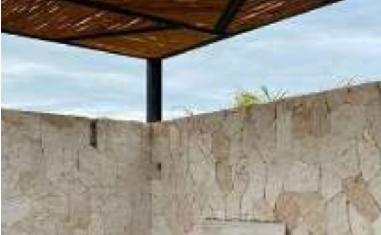
Cubierta de herrería y giles de madera
