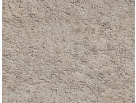
Aplanado con pintura vinílica
