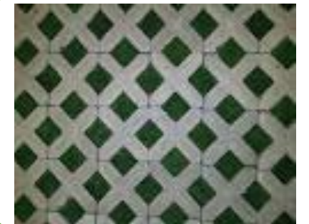
F Adopasto de concreto
