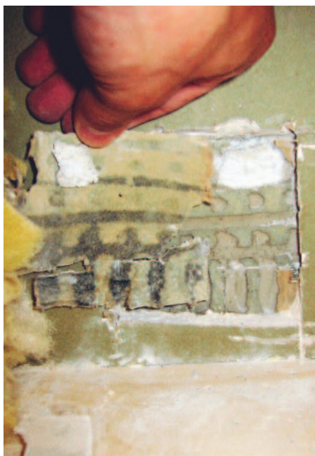
Bild 1: Skadad kartonggips.
