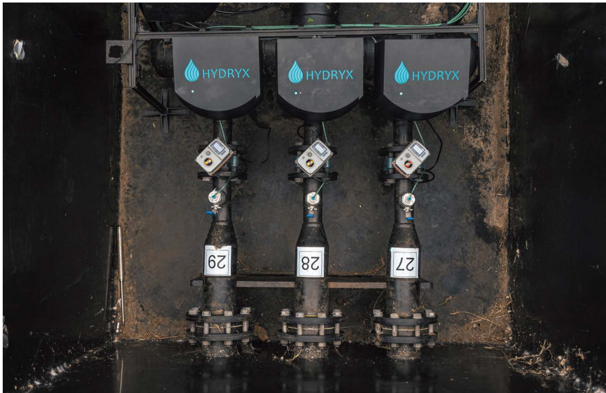
De kastjes met sensoren van Hydryx
