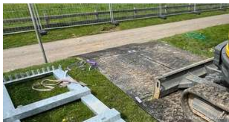
Schutz bei Wartungsarbeiten.
