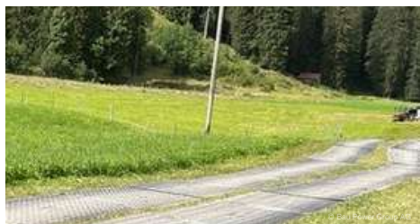
Temporäre Wege für den Landschaftsbau.
