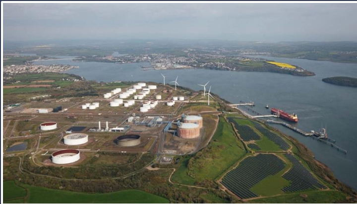
LNG terminal development Dragon Gas (2003)
