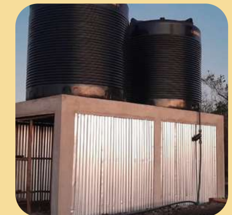
Watertoren & tanks geïnstalleerd. Uitdaging: vertraging in levering zonnepanelen. Oplossing: installatie voltooid, water stroomt!
