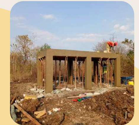
De bouw van de watertankplatformen
