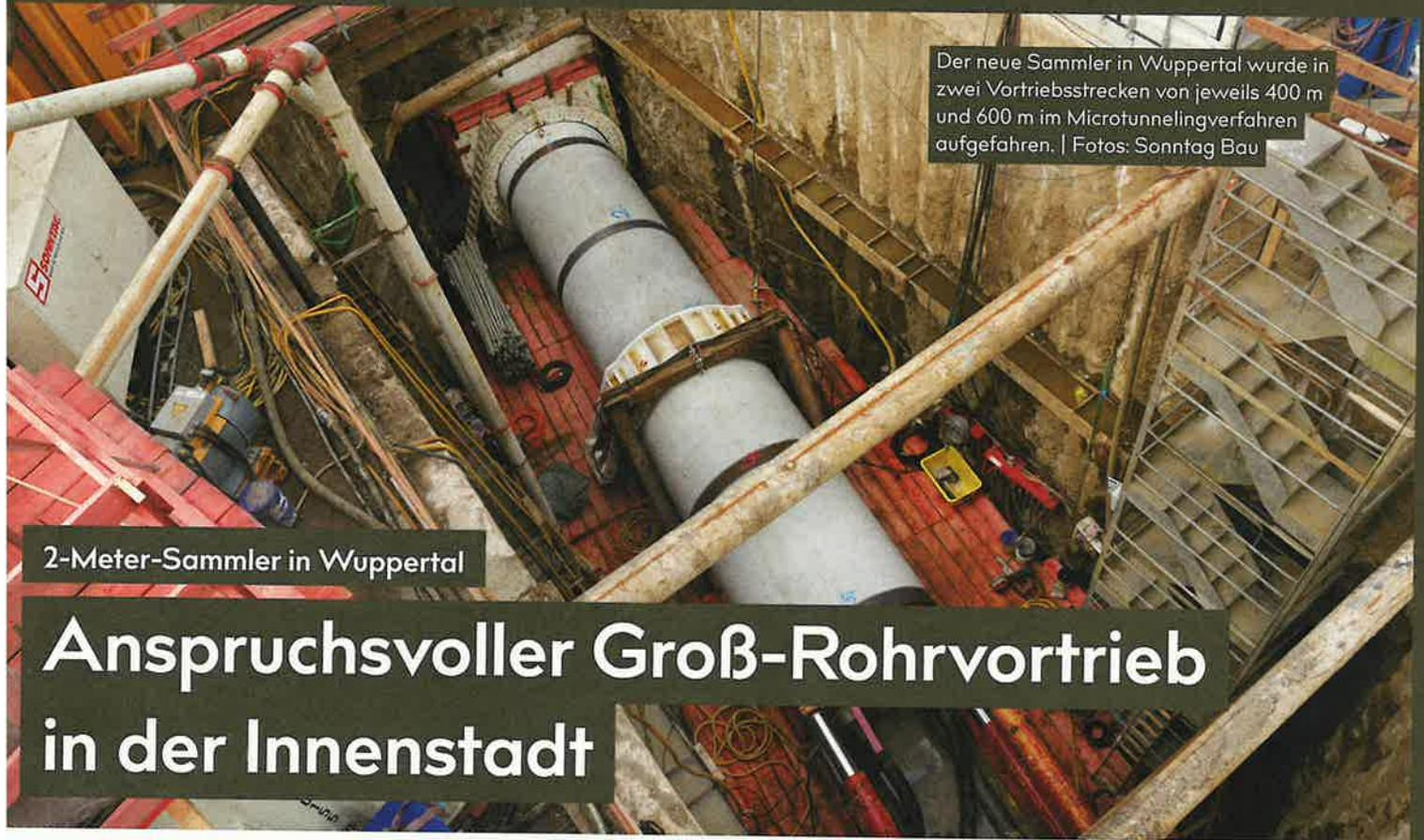
Der neue Sammler in Wuppertal wurde in zwei Vortriebsstrecken von jeweils 400 m und 600 m im Microtunnelingverfahren aufgeföhren. | Fotos: Sonntag Bau
