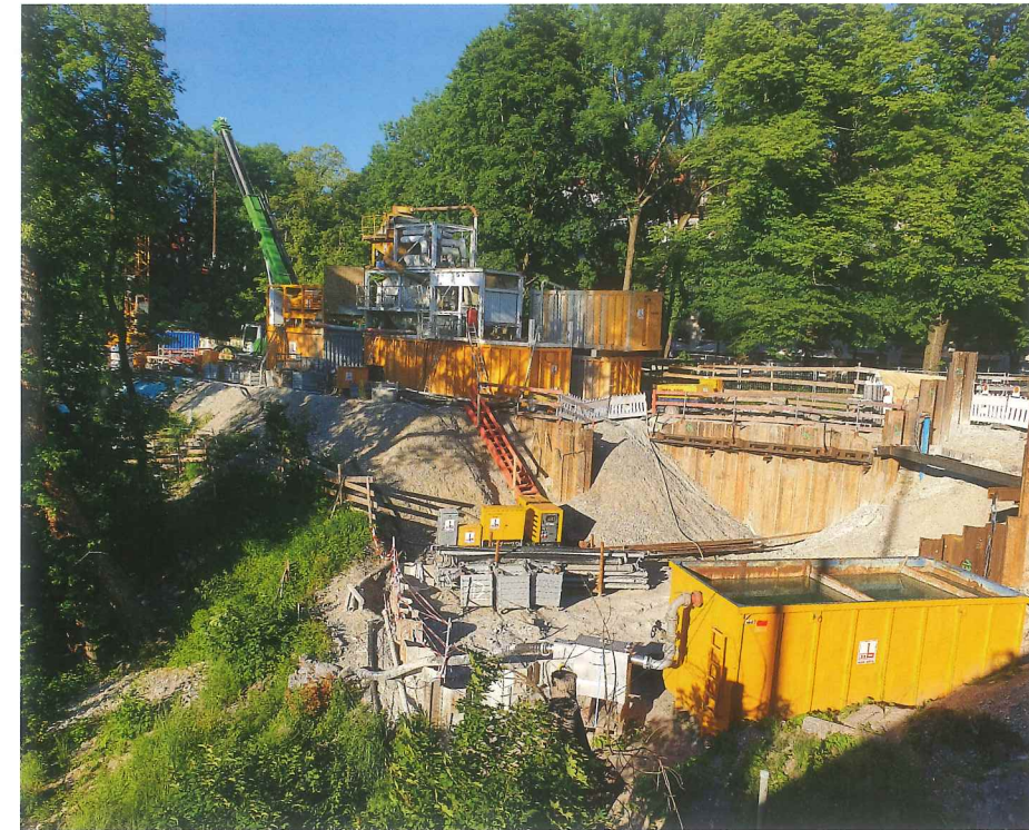
Innerstädtische Randbedingungen und eingeschränkte Platzverhältnisse erschwerten die Baustelleneinrichtung und die Herstellung der Startgrube. Hierfür mussten im Uferbereich der Isar im Vorfeld Aufschüttungen vorgenommen werden. | Foto: A. zu Eulenburg
