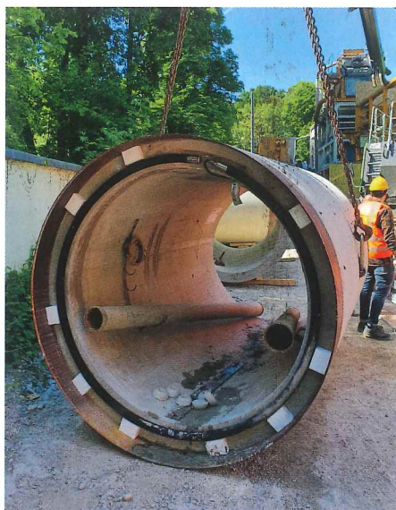
Die Hydraulische Fuge wurde in diesem Fall möglichst dicht an der Innenseite der Rohre angeordnet, um einen sauberen Innenabschluss der Rohrverbindung zu erreichen. | Foto: A. zu Eulenburg
