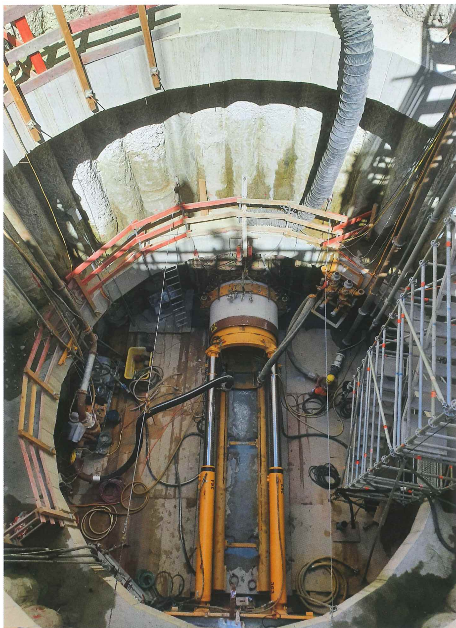
Blick in die 12 Meter tiefe Startgrube | Foto: A. zu Eulenburg
