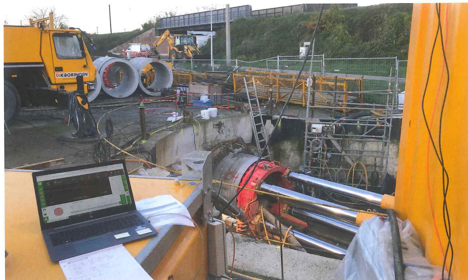
Baustellentest neue MSS-Software in Sint-Truiden, Belgien | Fotos: Jackcontrol
