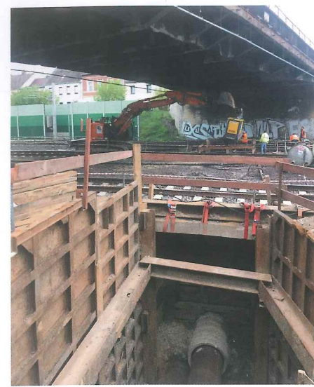
Zum Projekt der Deutschen Bahn am Knotenpunkt Roßlau gehörte die Herstellung einer Trägerbohl-Spundwandbaugrube.
