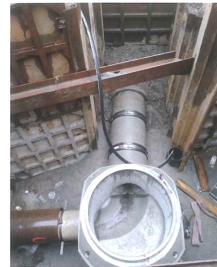
Bestandsschacht S43 mit GFK-Rohr DN 600 und Betonrohr DN 800 | Fotos: Echthoff
