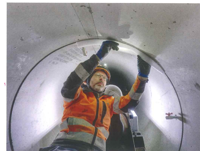
Abbildung 4: Einbringen des Schalungsstreifens in den Aussparungsbereich
