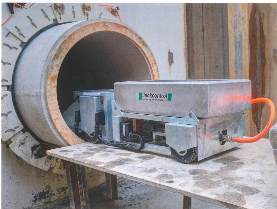
Abbildung 6: Ringraumverfüllung mit dem CT Rover
