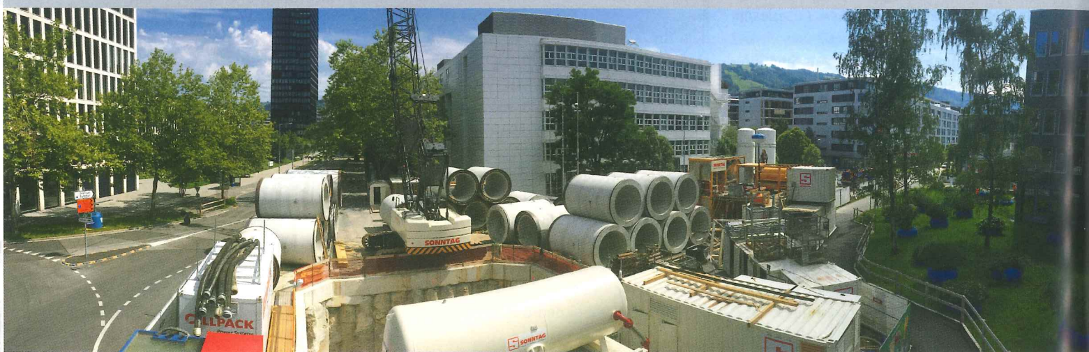
Blick auf die Baustelle | Fotos: Berding Beton
