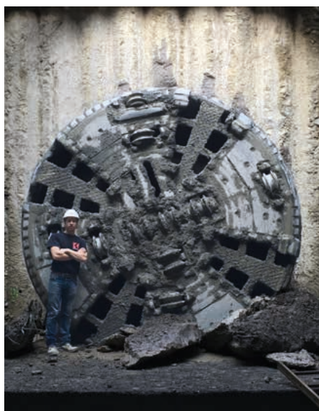
Durchstich nach dem erfolgreichen Vortrieb für das Kraftwerk Cotlan. Das Schneidrad ist bis zur Verschleißgrenze abgeschliffen. | Foto: K-Borings
