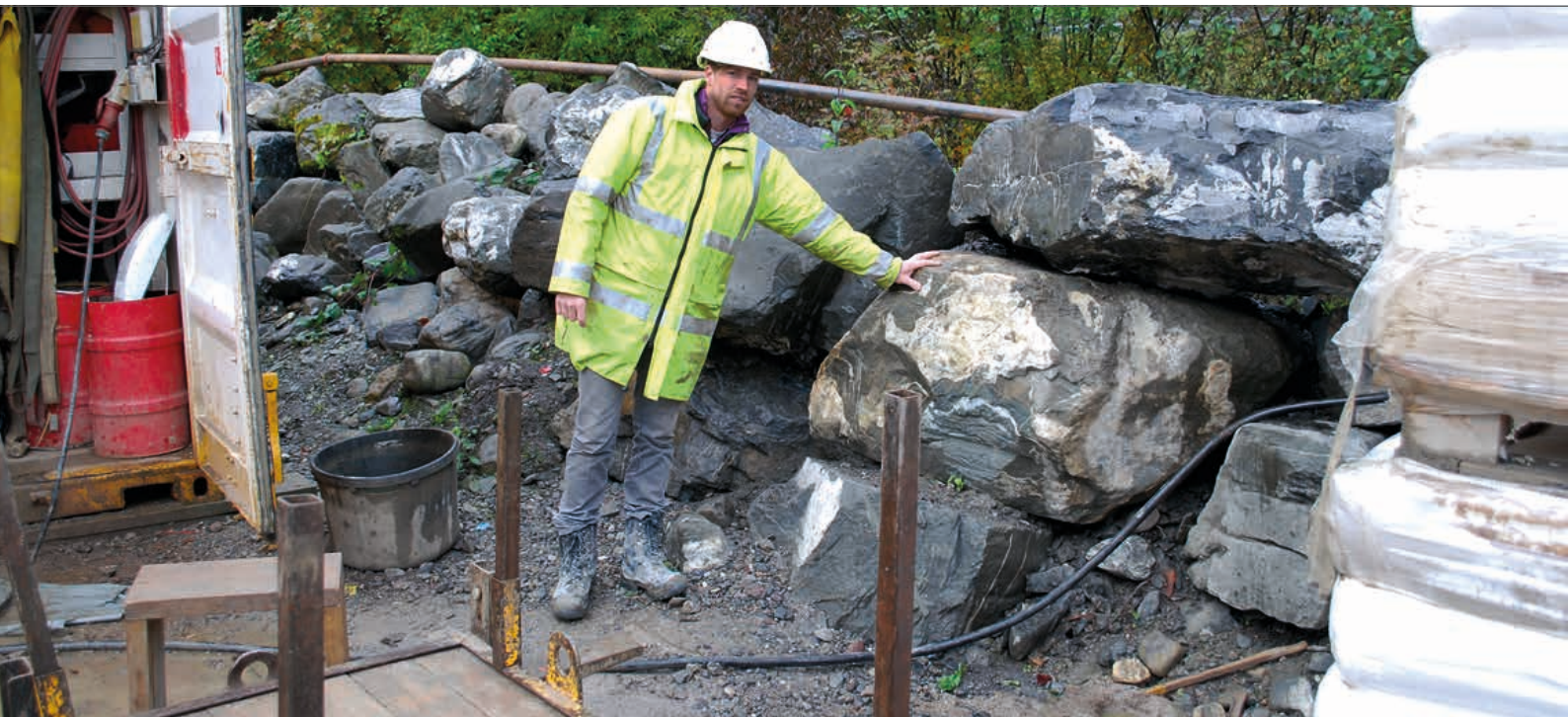
Stijn Philips zeigt auf Felsblöcke, wie sie bei den Vortrieben für die Kraftwerke Rufi und Cotlan im Baugrund anzutreffen waren. | Foto: A. zu Eulenburg
