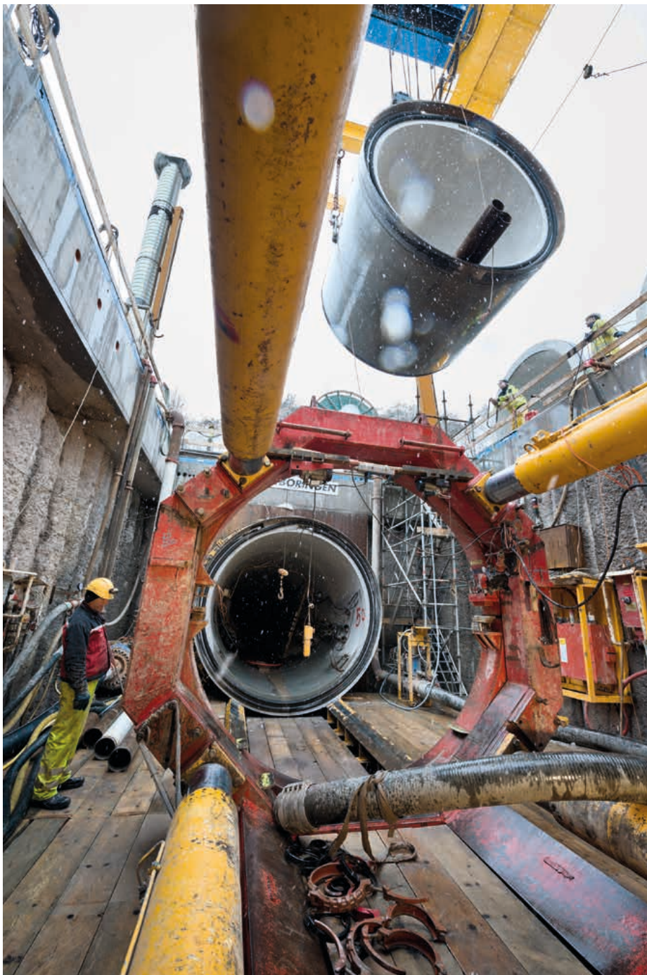
Aufgrund der engen Kurven kamen hier drei Meter lange Vortriebsrohre zum Einsatz. In der Rohrverbindung ist die hydraulische Fuge zu erkennen. | Foto: Herrenknecht
