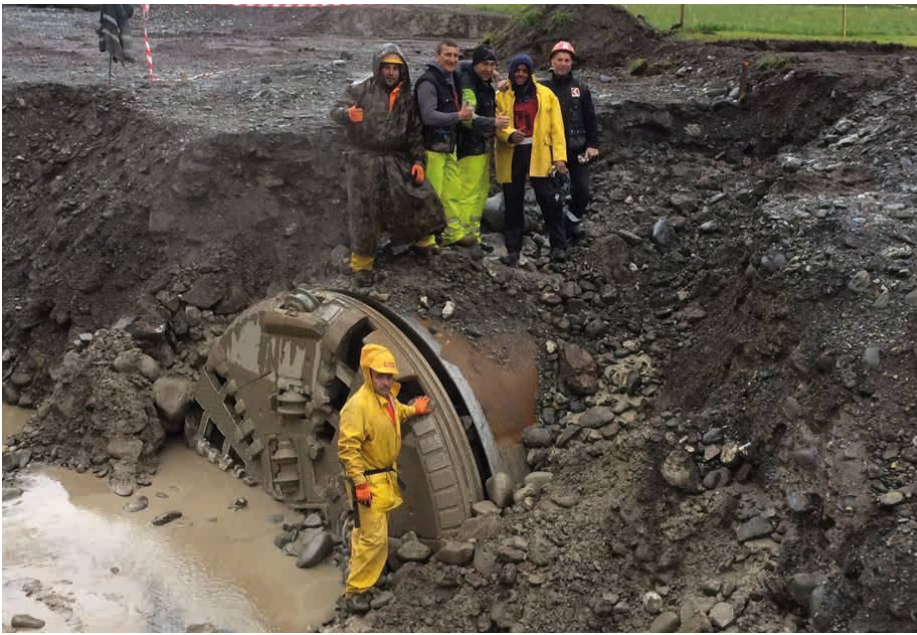
Nicht in einer Baugrube sondern an der Geländeoberfläche: „Auftauchen“ der Tunnelbohrmaschine nach dem Vortrieb für das Kraftwerk Rufi. | Foto: Jackcontrol
