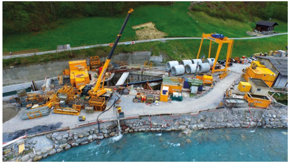
Baustelleneinrichtung rund um die Startbaugrube für den Stollen zum Kraftwerk Doppelpower. | Foto: K-Borining
