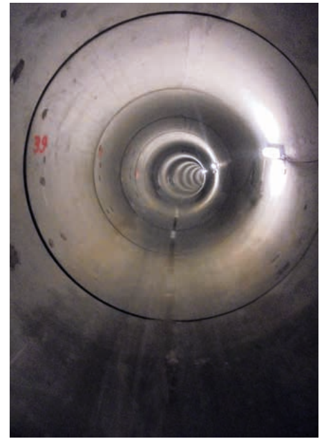
Der Blick in den fertigen Tunnel vermittelt einen Eindruck von dem engen Kurvenradius. | Foto: K-Boringen
