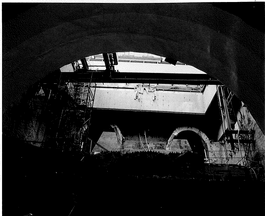
Der Teilabschnitt der DML aus dem Weinbergtunnel, welcher den Fluss Limmat unterquert, verläuft bis zum neuen Bahnhof Löwenstrasse nur 3–5 m unter dem denkmalgeschützten Südtrakt des Hauptbahnhofs. (Bilder: Curt Mayer)
