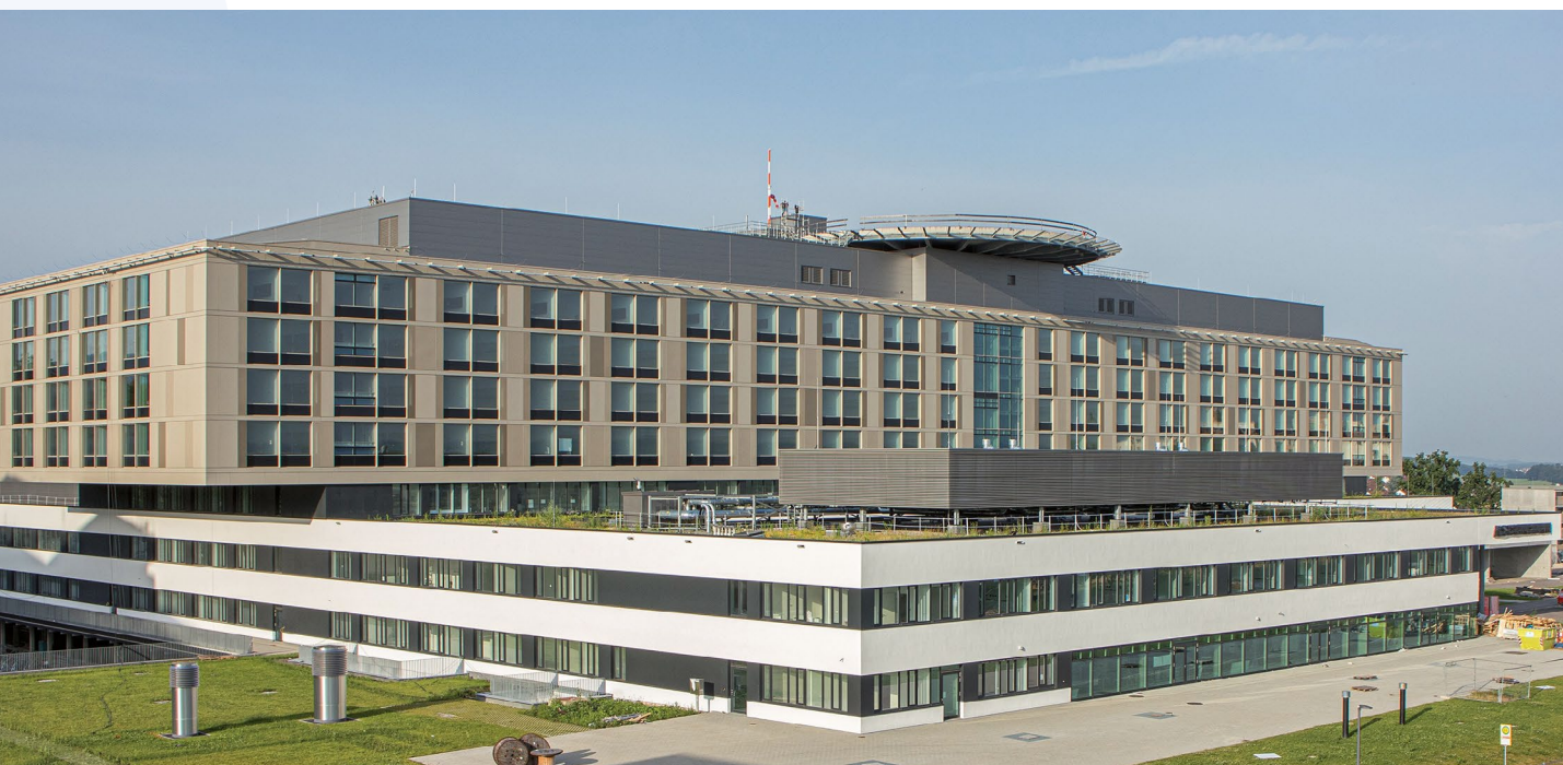
Das Alb Fils Klinikum hat im Neubau gemeinsam mit dem Smart-Cleaning-Spezialisten soobr ein digitales Auftrags- und Workflow-Management implementiert, das die Reinigung und die Bettenlogistik als vernetztes Gesamtsystem steuert.
