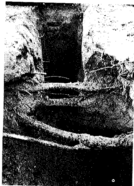
wortels en kabels in dezelfde ruimte (Rotterdam)
