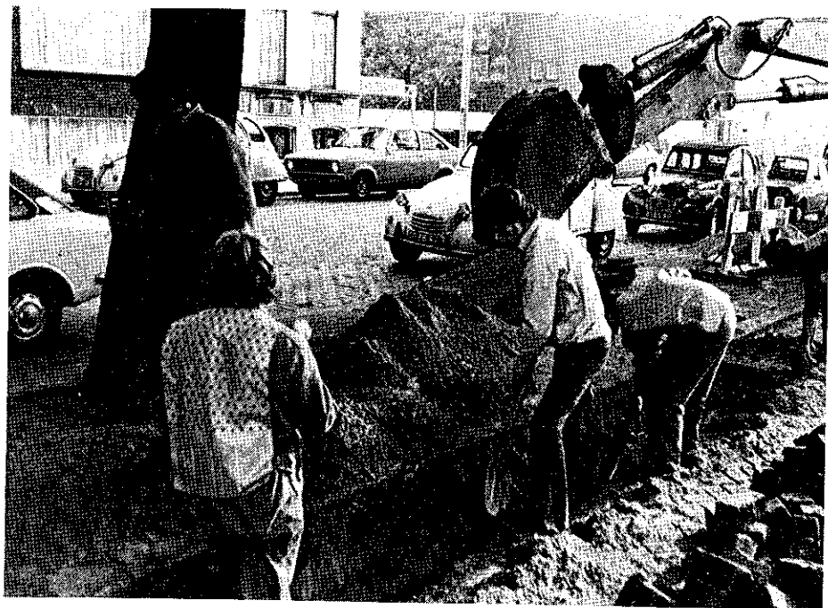
graafwerk in de wortelzone (Rotterdam).
