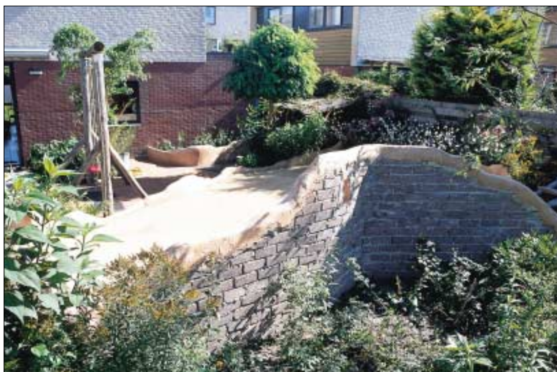
De lemen muren zijn gemetseld en vervolgens aangesmeerd. De achterkant is deels aangesmeerd.
