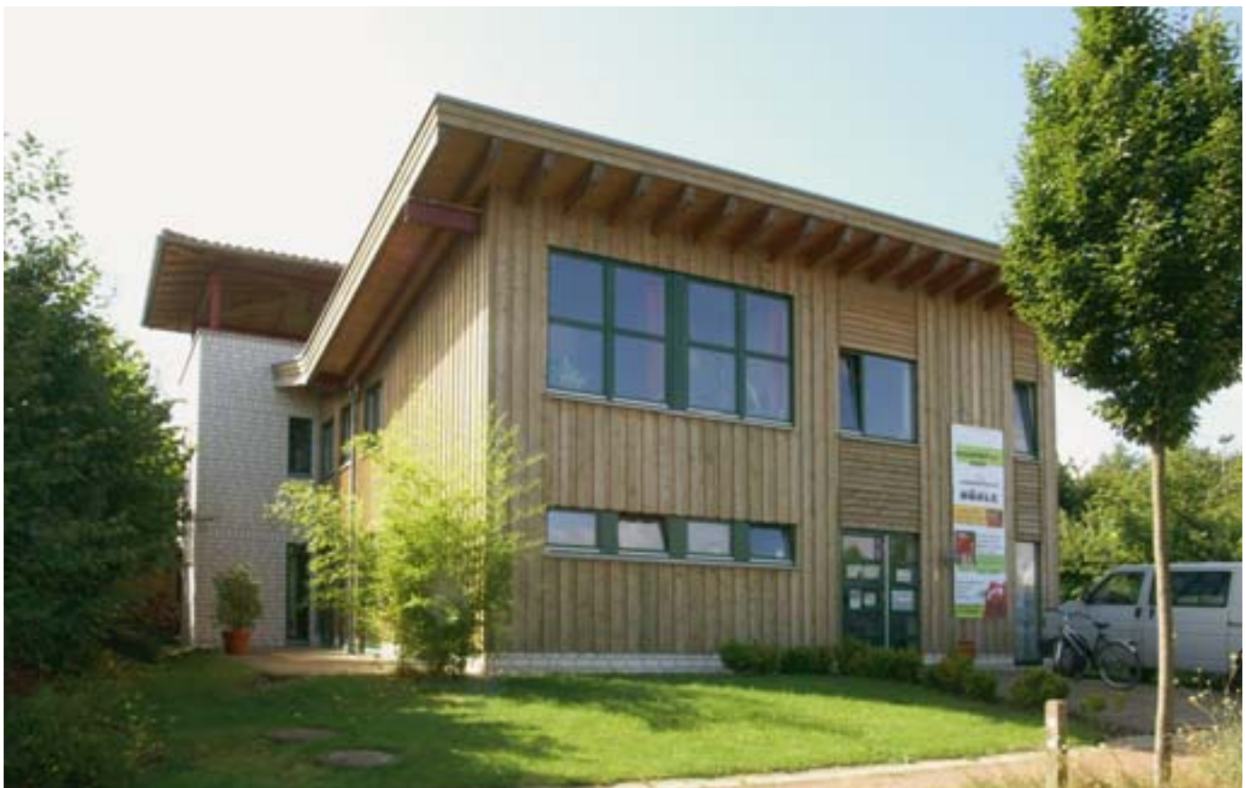
Zweigeschossiges Ateliergebäude in massiver Kalksandstein-Bauweise
