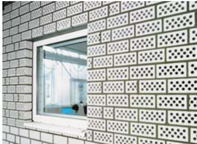
Bild 7: Schallschluckwand aus KS-Lochsteinen mit werkseitig durchstoßener Lochung
