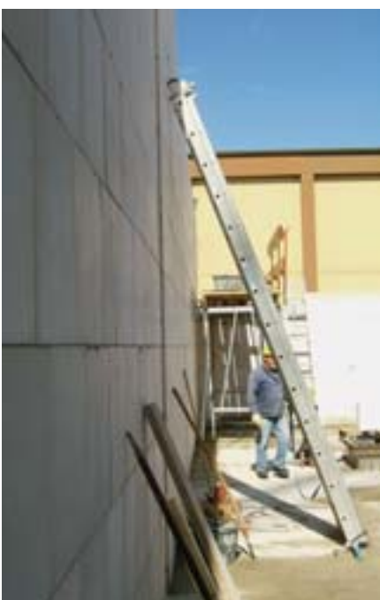
Beim Sprühlturm kamen KS XL-Rasterelemente zum Einsatz.
