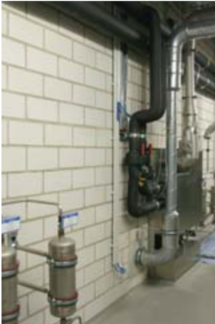
Leitungsführung und KS-Mauerwerk wurden sichtbar belassen.
