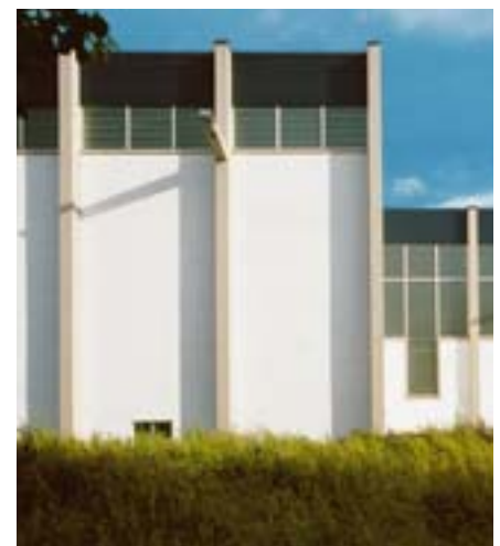
Bild 7: Produktionsgebäude mit nicht tragenden Außenwänden aus Kalksandstein.
