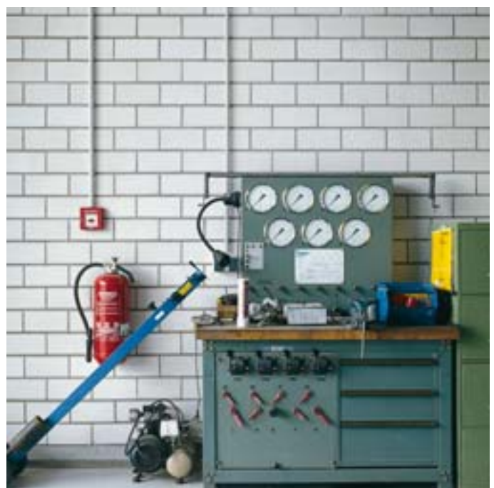
Hydrophobisiertes KS-Sichtmauerwerk sorgt bei Verschmutzung für leichte Reinigung.
