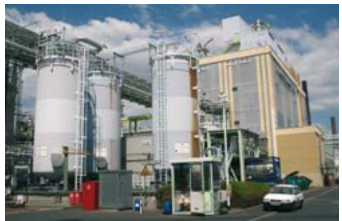
Bild 2: Gebäude der Chemischen Industrie
