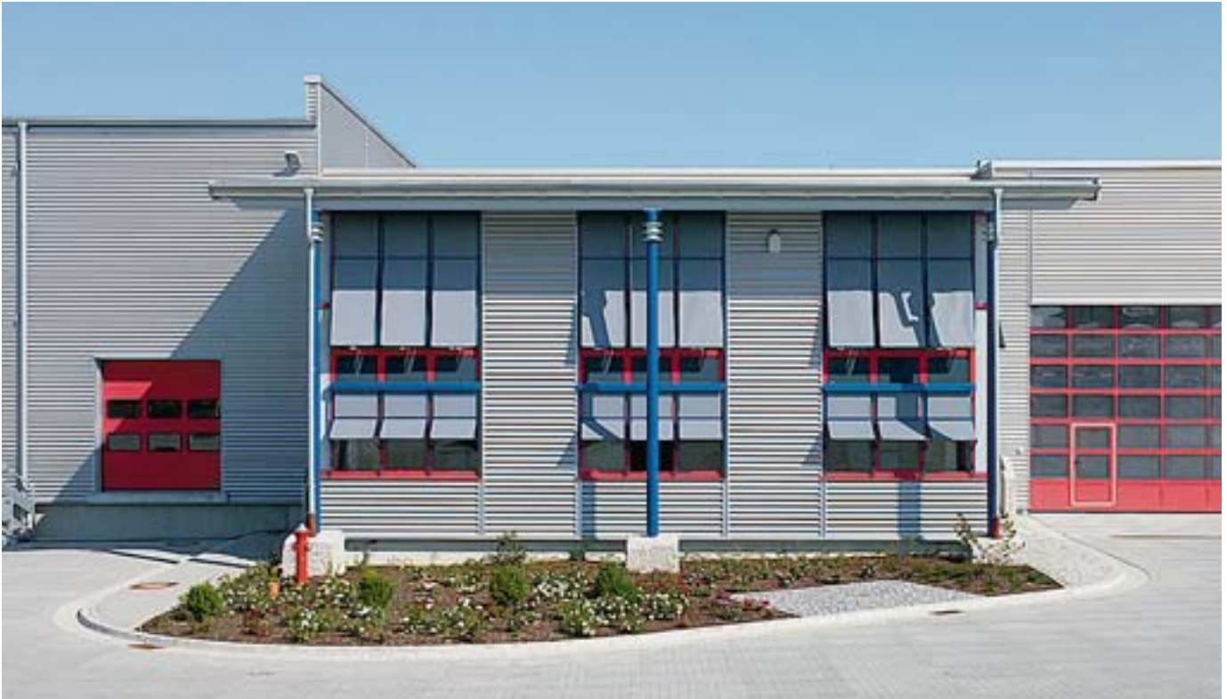
Silbern gestrichene Wellblechprofile verbinden die unterschiedlichen Gebäude.
