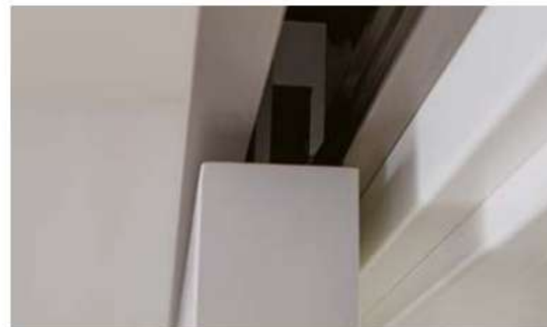
Befestigung einer Holztür im Schiebetürbeschlag SLIM
