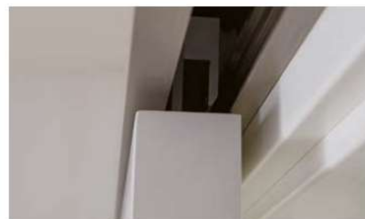
Befestigung einer Holztür im Schiebetürbeschlag SLIM
