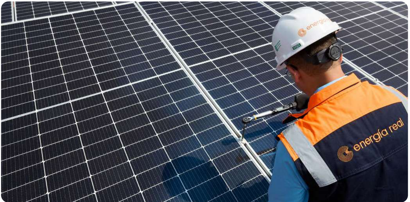
Encuentro Tlanepantla Industria Retail | PPA Solar On-Site | Potencia instalada: 196 kWp
