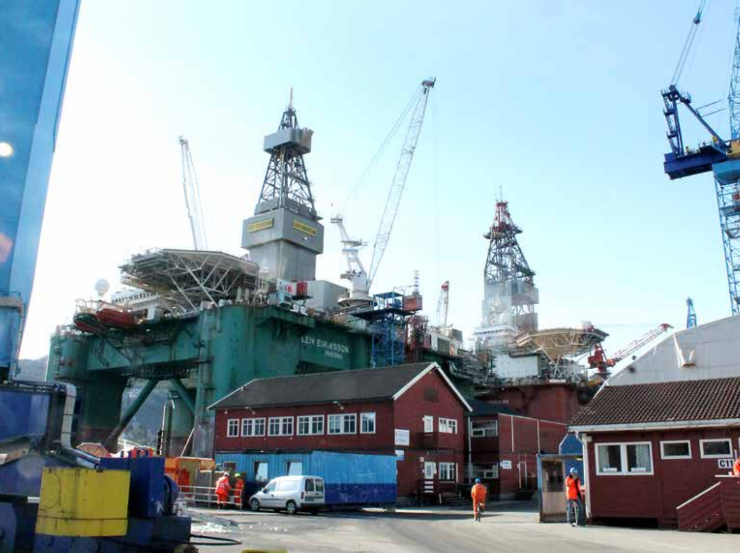
Et vanlig syn i Ølensvåg. Borerigge inne for reparasjon og vedlikehold.
