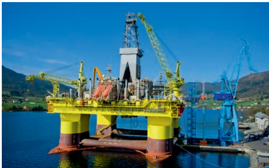
To klatrelag fra Westcon Løfteteknikk har vært i arbeid ombord på COSL Innovator siden før jul. Foto: Øyvind Sætre
