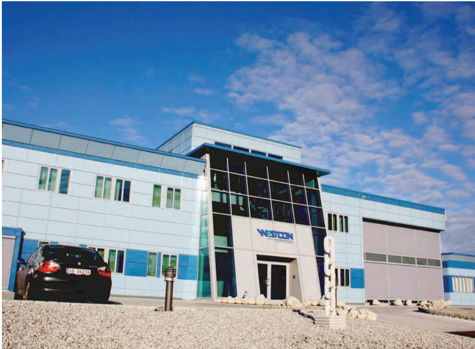
Nybygget på Hasseløy er utvidet med over 700 kvadratmeter.
