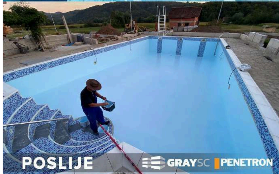
Sanacija privatnog bazena
