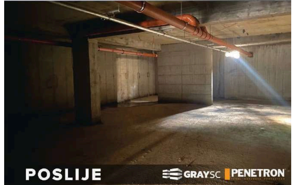
Sanacija stambeno-poslovnog objekta u Banjoj Luci
