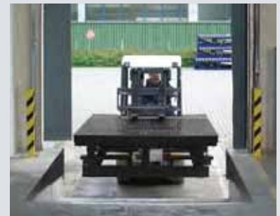
Neue Ladebrücke einsetzen
