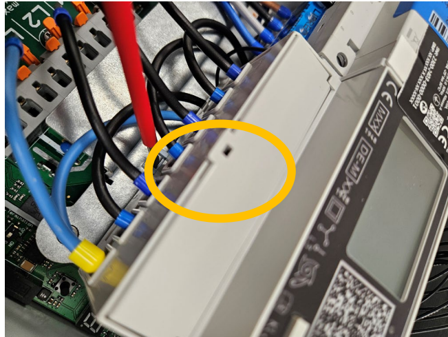
Abbildung 62 Zähler von Hutschiene lösen
