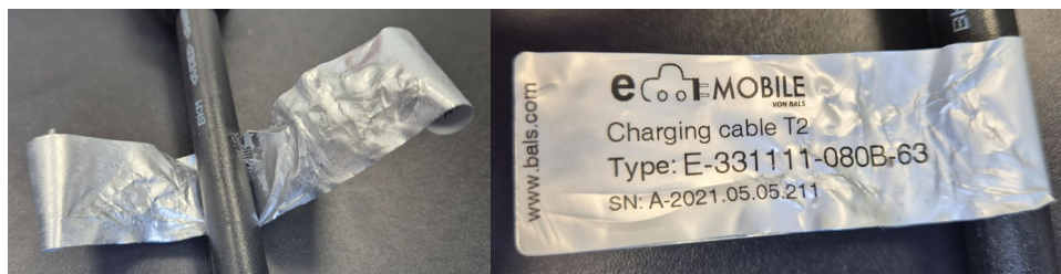
Abbildung 38 Beschädigte Klebebeschriftung des Kabeltypenschild mit sichtbaren Knickstellen
