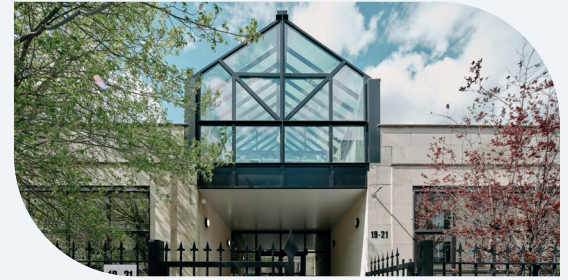
IMMEUBLE « BOULOGNE ST DENIS »
