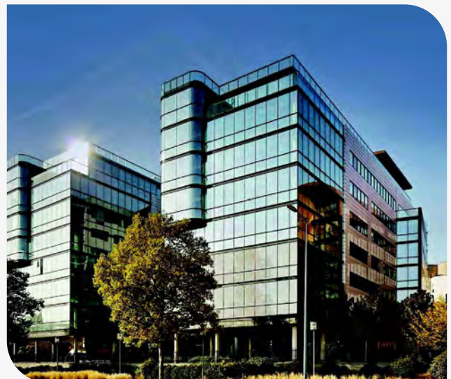
Immeuble « Seine Avenue » - Portefeuille PERIAL Grand Paris
