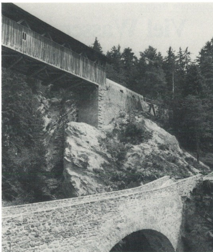
Unter der 110 Jahre alten Holzbrücke zwischen Brienzen und Alvaneu steht die alte Belfort-Brücke. Diese Steinbrücke, die kürzlich restauriert wurde, ist ein gutes Beispiel der alten Brückenbauweise (Tonnengewölbe). Der malerische Übergang über das tiefe Bachtobel soll in das Wanderwegnetz integriert werden und erhält damit als Fussgängerüberführung eine neue Zweckbestimmung. (Bild Jenny)
