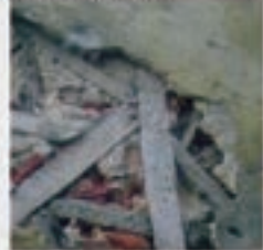
ANO. 11 - APODRECIMENTO DE ELEMENTOS DA ESTRUTURA DE PAREDE EM FRONTAL
