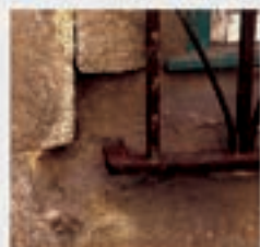
ANO. 06 - FRAGMENTAÇÃO DE CANTARIA DEVIDO A OXIDAÇÃO DE ELEMENTOS METÁLICOS
