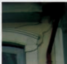
ANO. 01 - FISSURA DE ASSENTAMENTO NA PAREDE INCLUINDO LANCIL DE OMBREIRA
