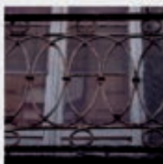
ANO. 08 - OXIDAÇÃO DE ELEMENTOS METÁLICOS (GUARDA-CORPOS)
