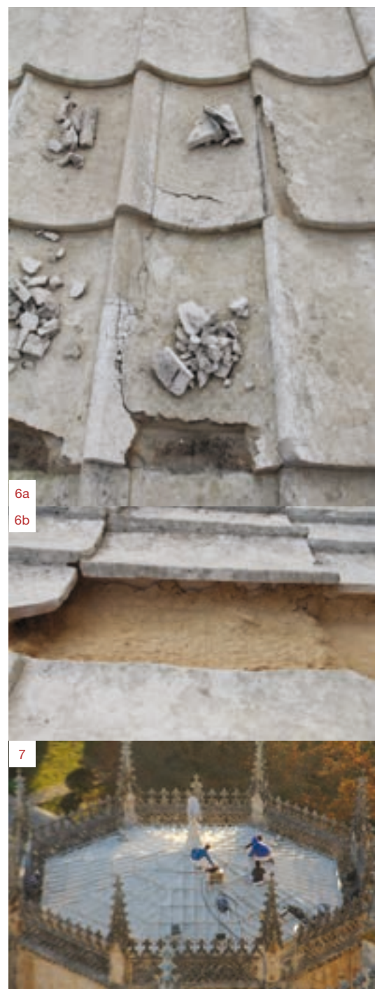
6 | (a) Aspeto da degradação pontual dos telhões; (b) Pormenor da fixação dos telhões de cantaria.
