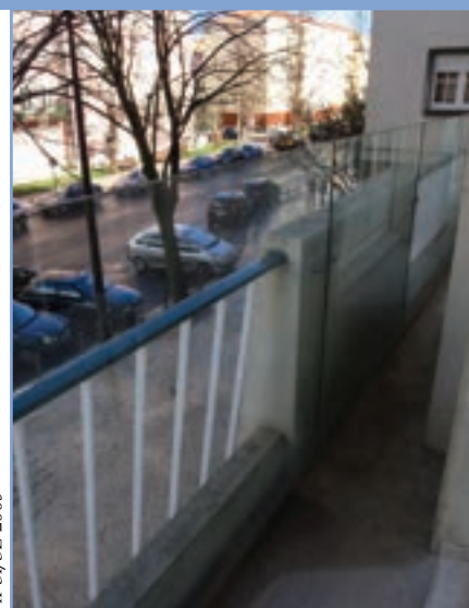
3 - Protecção de guarda, que apresentava distâncias excessivas entre prumos verticais, com elementos de vidro temperado ou laminado (edifício de habitação, Lisboa).
