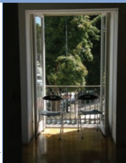
2 - Guardas que permitem escalamento pelo desenho e espaçamento dos seus elementos, a colocação das cadeiras facilita o acesso (Museu do Brinquedo, Sintra).
