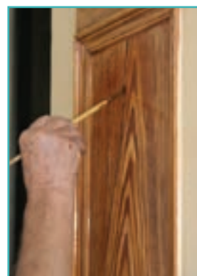
10 - Execução de veia de madeira nas portas.
