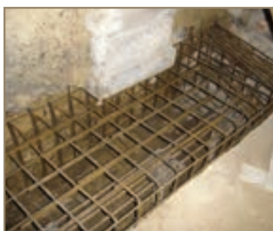
Armaduras dos maciços de encabeçamento das microestacas.
