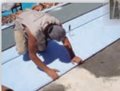
Aplicação de reforço da protecção térmica de uma cobertura inclinada.
