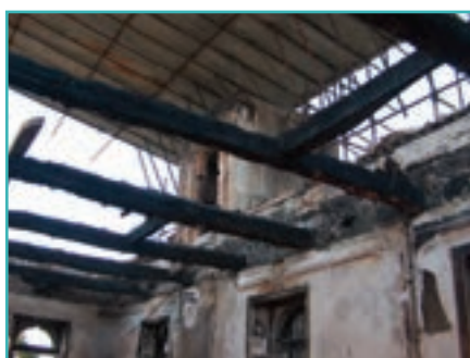
2 - Aspecto da estrutura após o incêndio.
