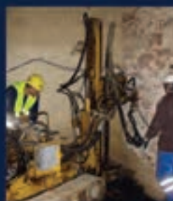
Execução de micro-estacas de reforço das fundações de um edifício antigo
