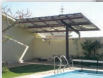
Recurso a sistemas solares activos (instalação solar fotovoltaica).
