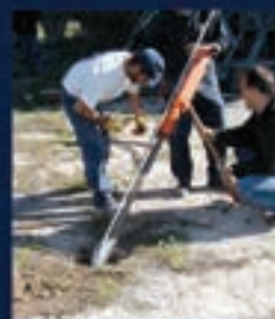
Cravação de ancoragem pré-tensionada para travamento de estrutura provisória
