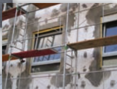
Aplicação de reforço da protecção térmica de fachadas pelo exterior.
