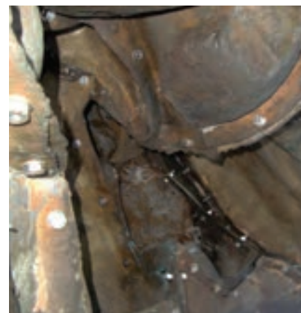
2 - Ligações entre peças em bronze por meio de aparafusamento interior
