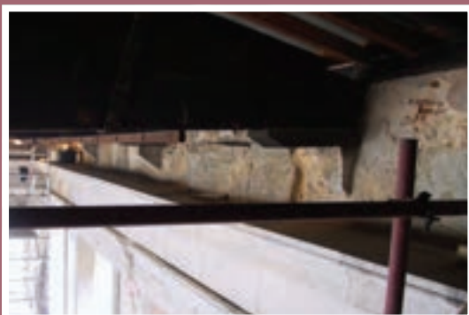
Cachorro de pedra fracturado
