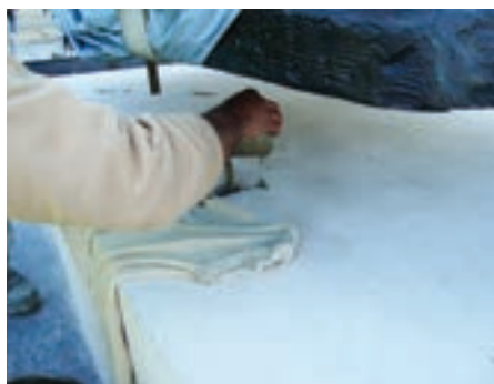
8 – Preenchimento/selagem de negativos para fixação dos pernos de apoio com recurso a argamassa de base epoxídica
