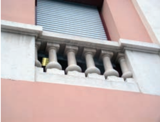
2 – Anomalia. Tipologia: acumulação de sujidade; localização: zona inferior das pilastras das janelas; extensão: média; urgência na reparação: média
