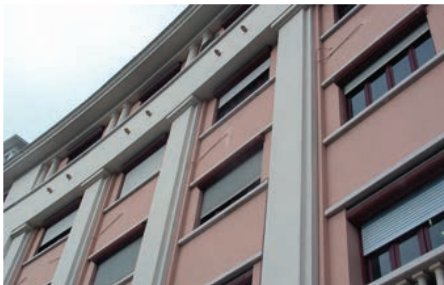
1 – Anomalia. Tipologia: deficiências ou lacunas na pintura; localização: parede, junto aos tubos; extensão: média; urgência na reparação: mínima
