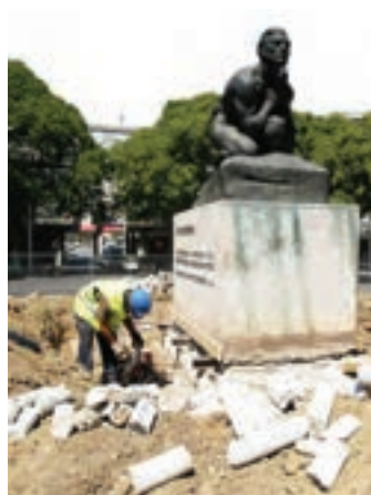
3 – Execução de carotes na fundação para recorte e posterior elevação
