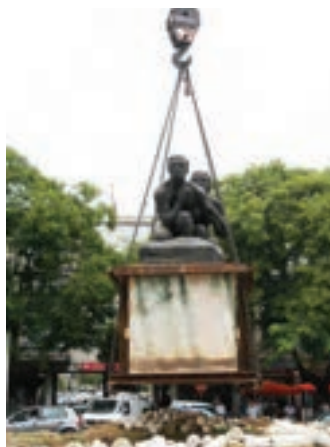
4 – Elevação do monumento, com estrutura exterior de protecção física e de suporte
