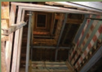
8 – Reforço da estrutura das escadas
