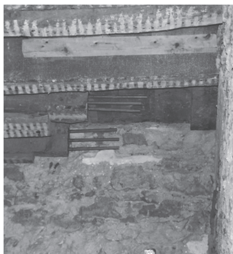
2 - Injecção de cola epoxídica nos furos para instalação dos varões
