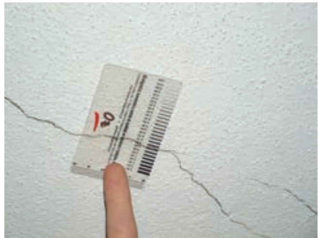
5 – Anomalia: fissuração (0,85mm); localização: laje de suporte; extensão: média; urgência na reparação: máxima
