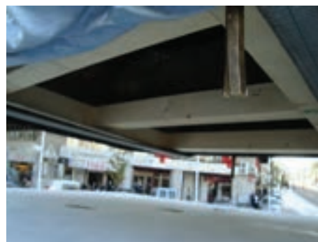
7 – Pormenor da estrutura de contenção interior, prevenindo deformações na elevação e transporte
