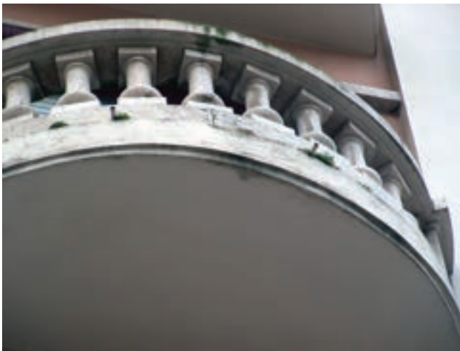
4 – Anomalia. Tipologia: vegetação; localização: junto das pedras e capeamentos; extensão: elevada; urgência na reparação: máxima
