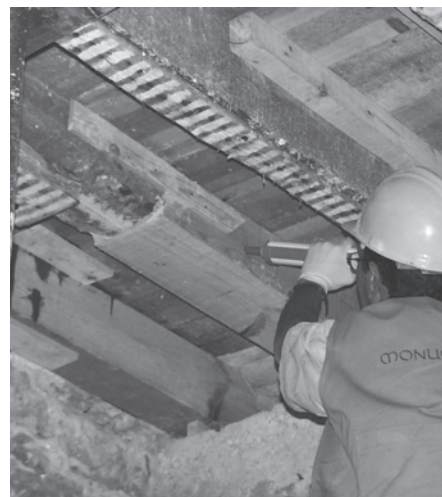
4 - Injecção de calda epoxídica nos entalhes
