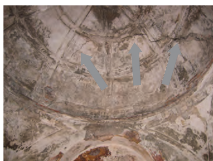
Intradorso da cúpula. Fractura
