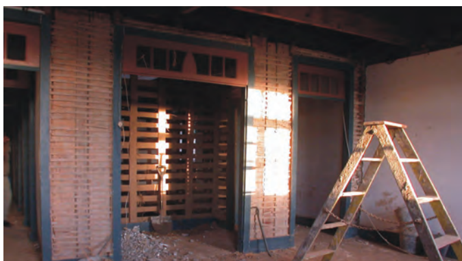
Remoção dos rebocos
