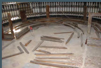
Peças únicas e originais da bancada em ferradura do Anfiteatro utilizadas no restauro
