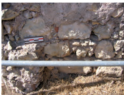
Parede Nascente. Aspecto da alvenaria da fundação. Juntas desguarnecidas
